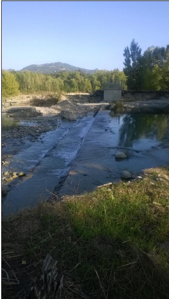
**Figura 1-3.** Area soggetta ad erosione durante l'evento del 12 dicembre 2017: aggiramento in sinistra della stazione idrometrica e scopertura del sifone.
