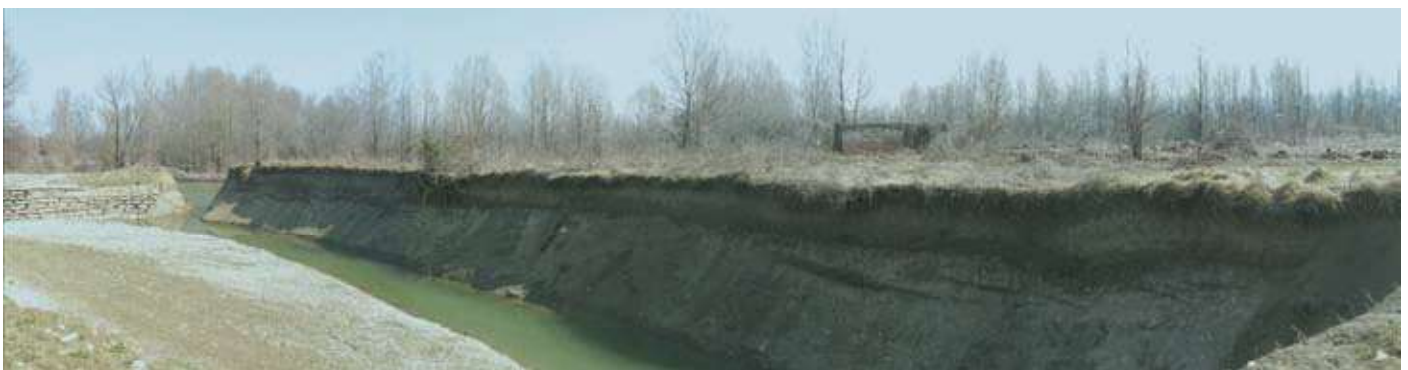
Realizzazione di interventi di ingegneria naturalistica sulla sponda prospiciente il Torrente Termina
