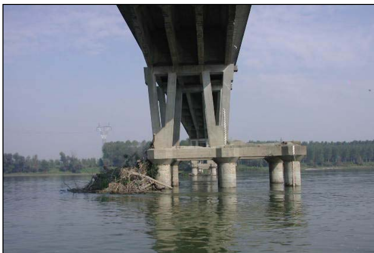
Foto 4 – Materiale vegetale flottante in corrispondenza delle pile di un ponte nel pavese
