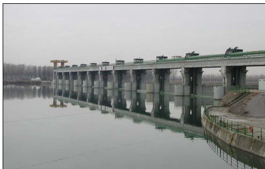
Foto 1 – Sbarramento di Isola Serafini
