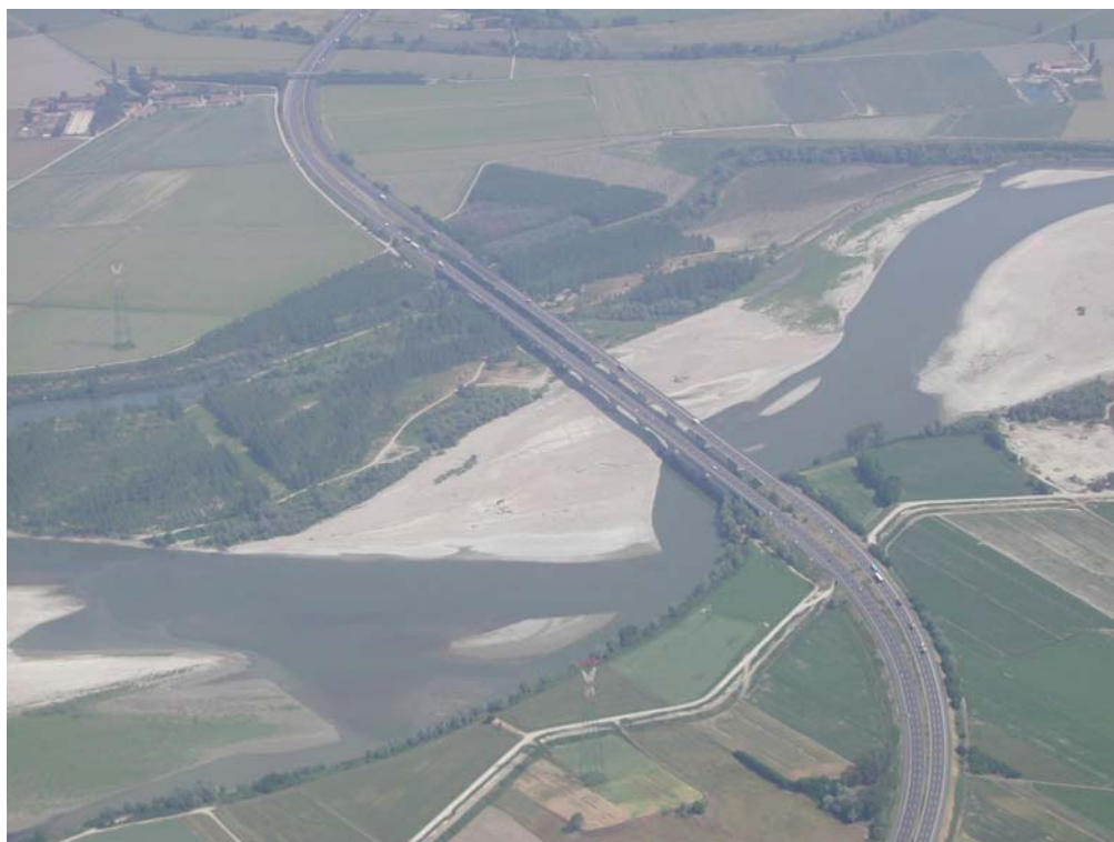
Foto 5 – Ponte autostrada A7
