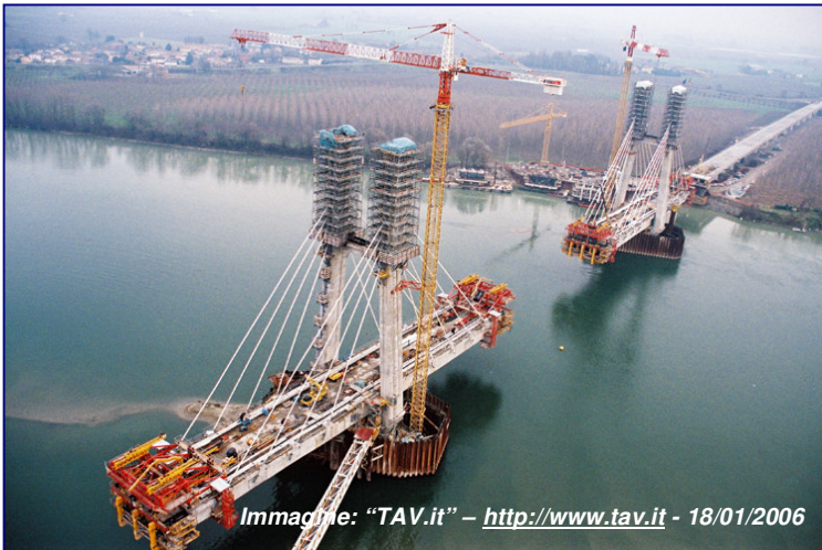
Ponte sul Po a Piacenza - Cantiere
