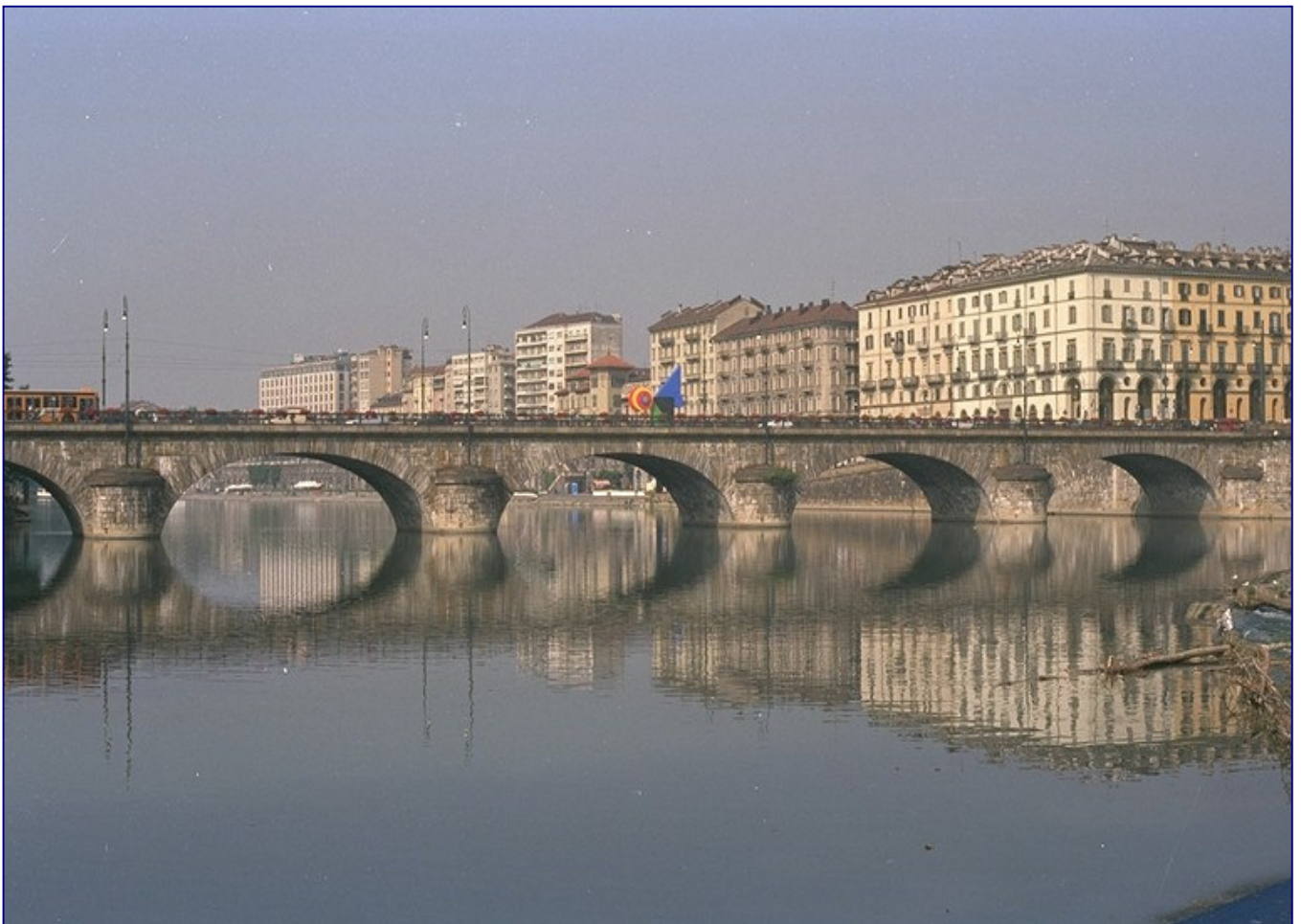
Torino – Ponte sul Po di Piazza Vittorio Veneto (Ponte Vittorio Emanuele I).
