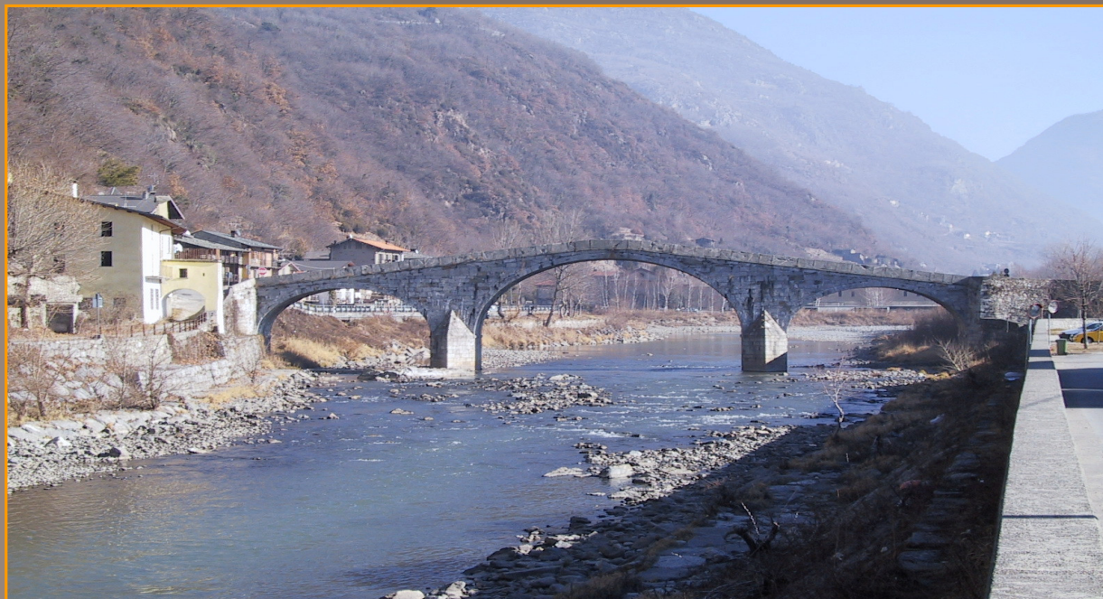
Ponte di Ganda – fiume Adda in Morbegno (SO)
