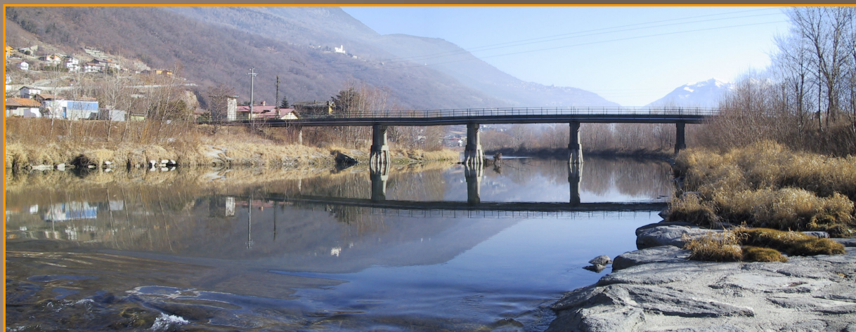
ponte sul fiume Adda a Mantello (SO)
