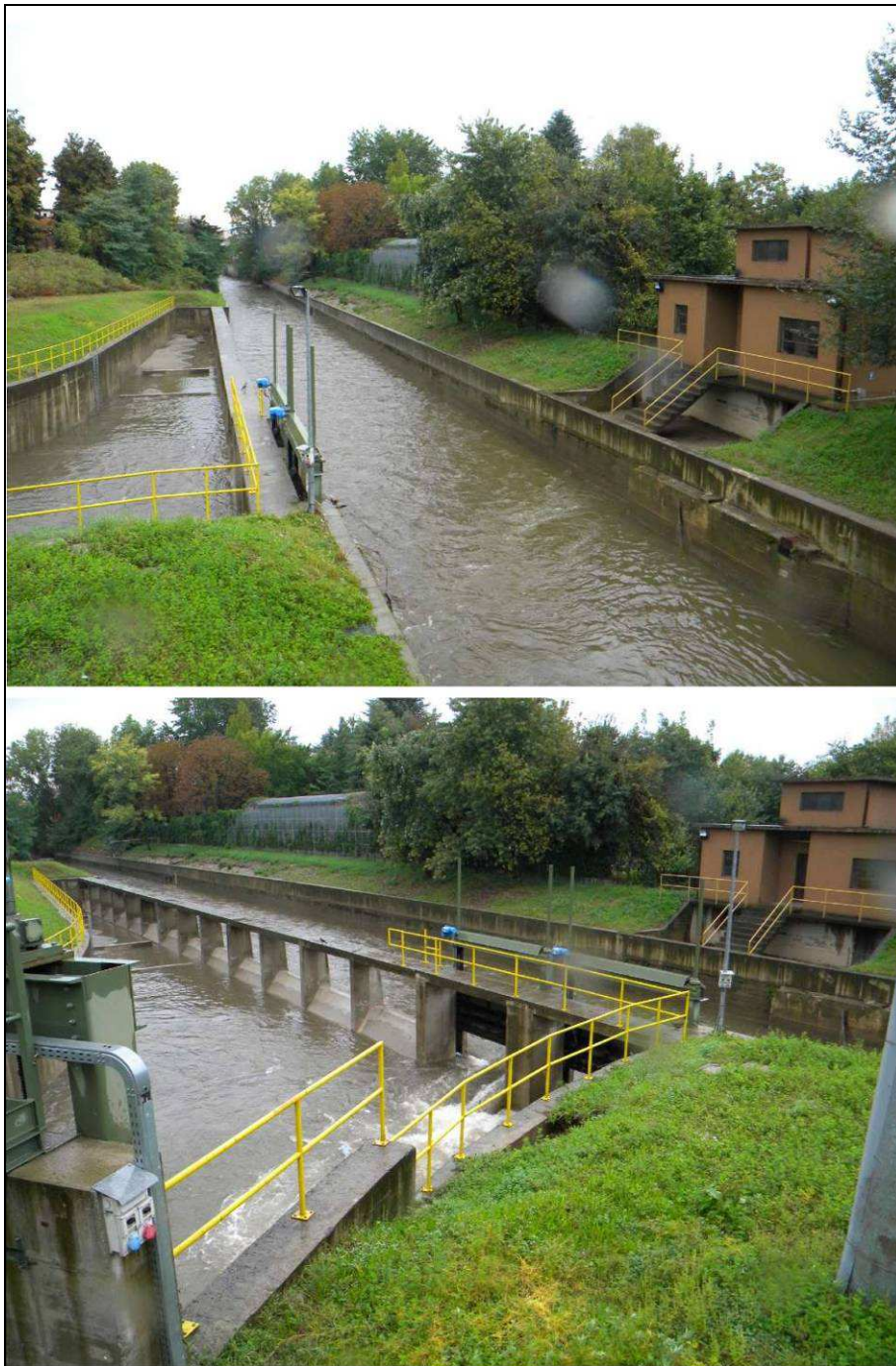
Figura 9 - Opera di presa C.S.N.O. vista da valle
