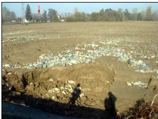
Figura 3. Settore a valle del rilevato della SP 179 dopo il passaggio della piena del 2011. In primo piano gli effetti morfologici causati dalle acque fuoriuscite dai sottopassi idraulici in secondo piano edifici interessati dalle piene
