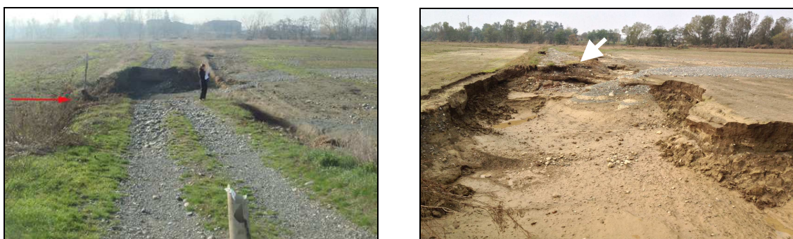
Figura 8. Comune di Bosco Marengo, sponda destra all'altezza della loc. Portanuova (sponda sinistra), effetti del passaggio dei deflussi in occasione dell'evento del nov 2011 (foto a sinistra) e del dell'ottobre 2014 (foto a destra) la freccia rossa indica la direzione del deflusso; la freccia sulla foto a destra indica il danno causato dall'evento del 2011 e, in primo piano, il rilevato asportato dall'evento del 2014.
