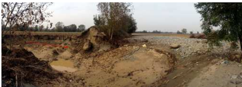
Figura 11. Panoramica della rottura arginale a valle del rilevato autostradale. La freccia indica la direzione dei deflussi. Si osservi il ventaglio di sedimenti grossolani (anche con blocchi di dimensioni decametriche), provenienti dalle lenti ghiaiose del complesso alluvionale del substrato (il rilevato arginale è costituito per lo più da sedimenti più fini).
